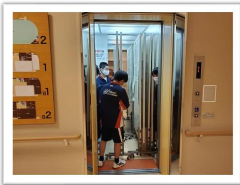
<ボードを運んでいます。結構重いです>
