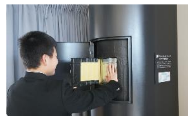
クールヒートトレンチダクトに触れる事で温度差を実感できる
