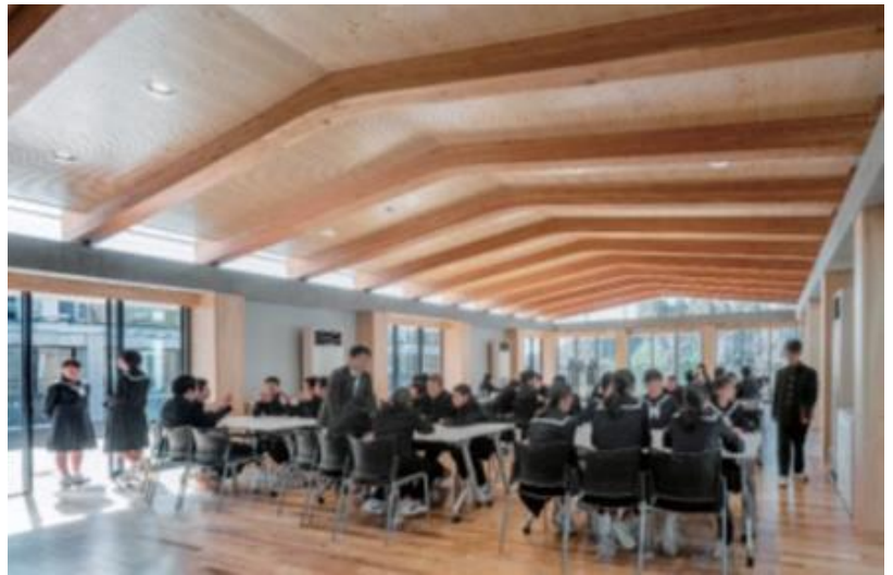
温かみのある内装：木造と勾配屋根で光を入れた教室事例 瑞浪市立 瑞浪北中学校
